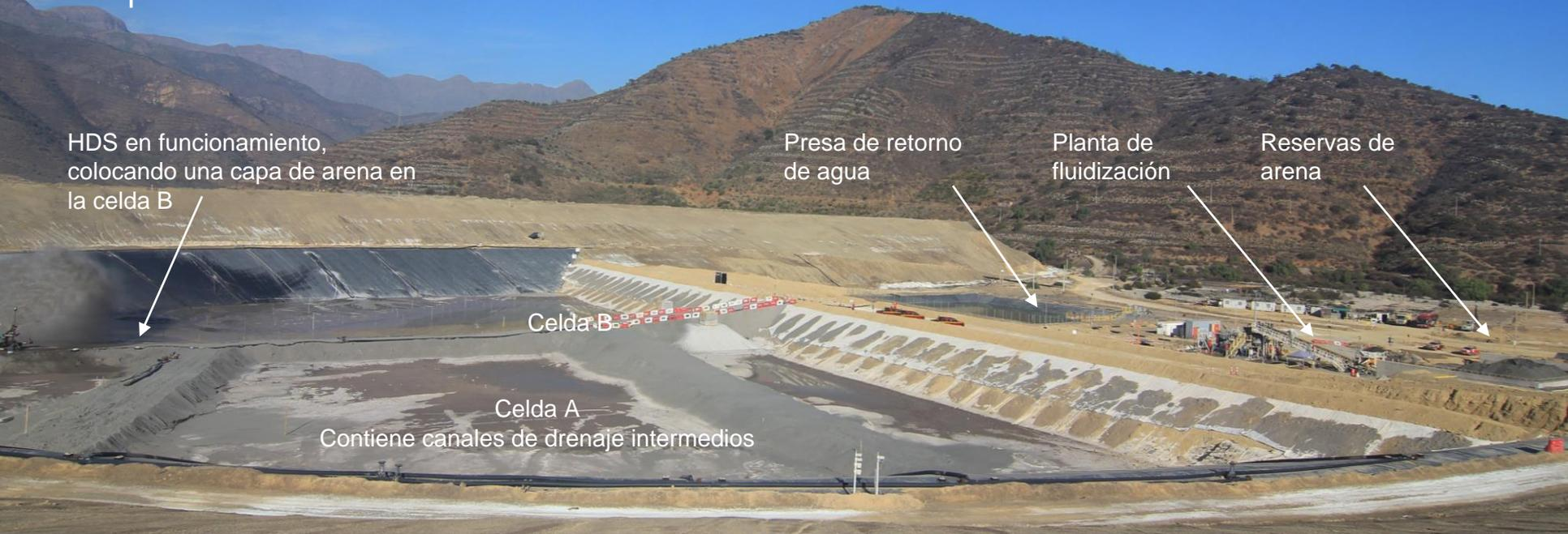
El apilamiento hidráulico deshidratado (HDS) es un método de depositación que utiliza arena libre de finos, normalmente derivada de los propios relaves, para crear canales de arena que facilitan el desagüe y aceleran la consolidación de los relaves.
